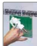
Accès au réservoir
