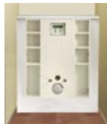
3 - Ajuster et poser les finitions (tablette, fileurs et plinthe)
