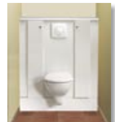
4 - Poser la cuvette, la plaque de commande et les portes
