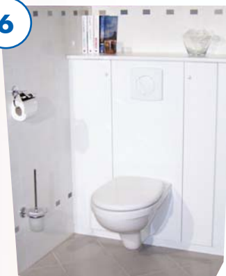
Installer la plaque de commande et la cuvette
